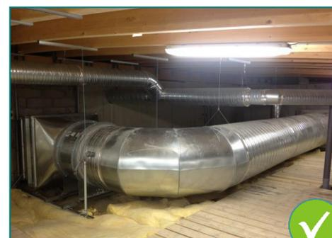
4 : Installation en conduits rigides correctement réalisée
