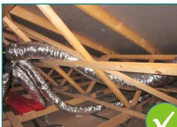
1 : Conduits souples correctement mis en œuvre (pas d'écrasement ni de coude supérieur à 90°)
