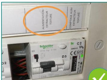
1 : Disjoncteur individuel et identifié pour la ventilation avec « Alimentation extraction toiture »
