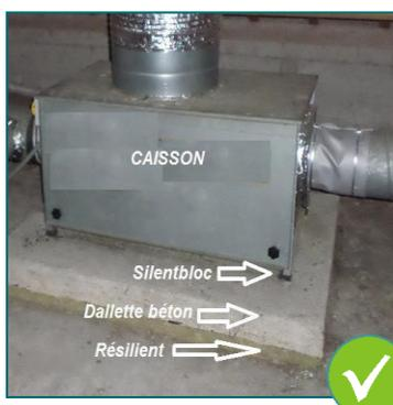
2 : Caisson correctement installé avec des éléments anti-vibratiles
