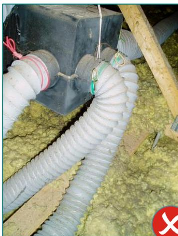
3 : Raccordements mal réalisés avec risque de débranchement
