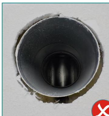
2 : Absence de dispositif de raccordement
