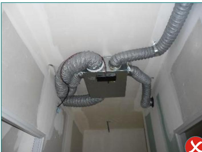
3 : Coudes importants directement au niveau des raccordements sur le caisson de ventilation en maison individuelle
