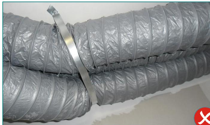
5 : Ecrasement des conduits souples par l'élément d'attache
