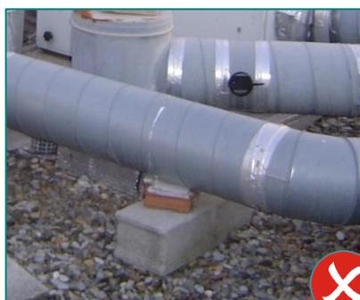
3 : Conduit rigide horizontal avec support NON adapté
