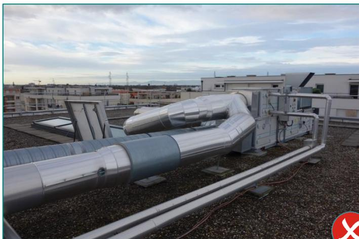
2 : Embranchement directement en sortie de caisson de ventilation
