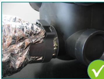
2 : Raccordements correctement réalisés avec colliers de serrage
