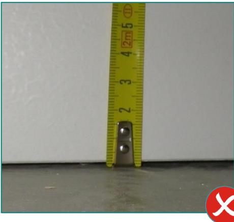
2 : Détalonnage insuffisant
