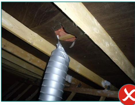
2 : Rejet NON raccordé sur l'extérieur (refoulement dans les combles)
