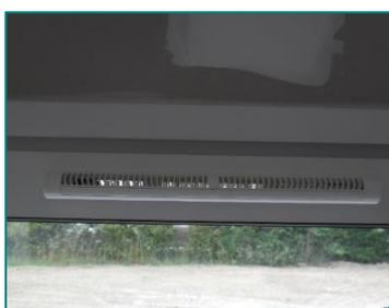
4 : Entrée d'air correctement mise en œuvre
