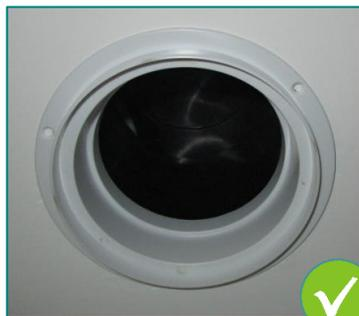
1 : Conduit raccordé avec une manchette de raccordement correctement installée
